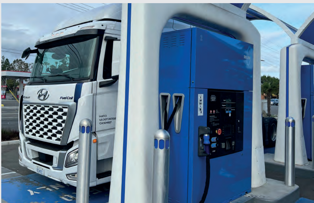
Grazie alla criopompa, le stazioni non richiederanno serbatoi di stoccaggio temporanei. Thank to the cryopump, the stations will not require temporary storage tanks.
