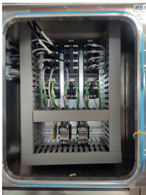
Le Safety Fieldbox SFB sono moduli di connessione da campo per collegamenti fail-safe dei dispositivi.
