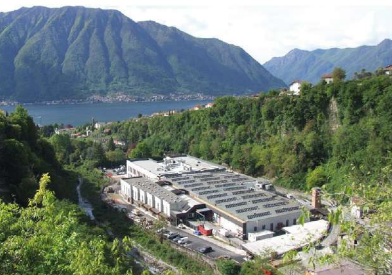
Nella foto: la sede ABB di Tremezzina, Loc. Ossuccio (fabbrica e uffici)
