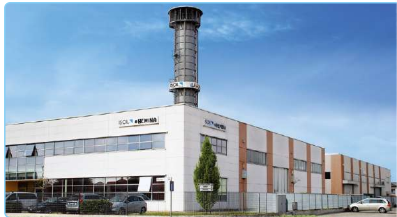
Centro di produzione di Montagnana (PD) con il torrino di taratura sullo sfondo.
